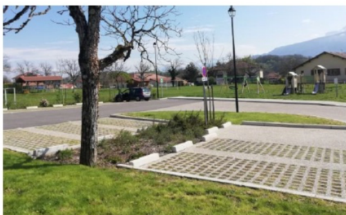
Revêtement perméable, parking de l'école municipale à Chantesse (illustration)
