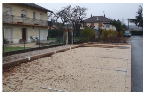
Aire de stationnement perméable en graviers agglomérés, Saint-Sauveur (illustration)
